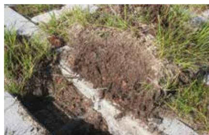
Pour des pavages végétalisés subissant des passages véhiculaires importants, un terreau structurant est recommandé dans le but de réduire le tassement des alvéoles végétalisées.
