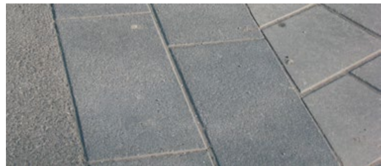
Sur cette ouvrage, l'enrobé bitumineux sur-épaissi (à gauche sur la photo) sert d'élément de confinement aux pavés TLI 200 mm Crescendo 320 .
