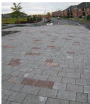
Figure 1 Construction d'une section courbe de pavage
