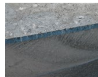
Figure 5 Reconstruction du chanfrein à la scie d'un pavé coupé.
