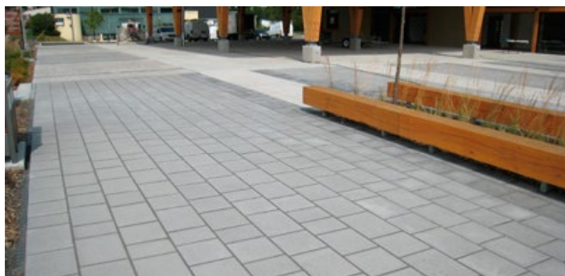
Figure 2 Le déphase des joints transversaux lors de la construction des lisières de pavés multi-longueurs permet d'optimiser l'esthétique et la performance de l'ouvrage.
