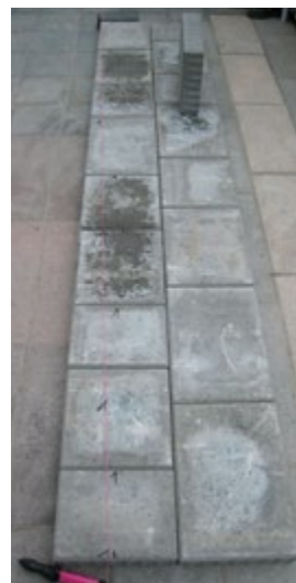
Figure 4 Préparatifs de coupe des pavés d'une lisière à l'aide d'un cordeau tendu.
