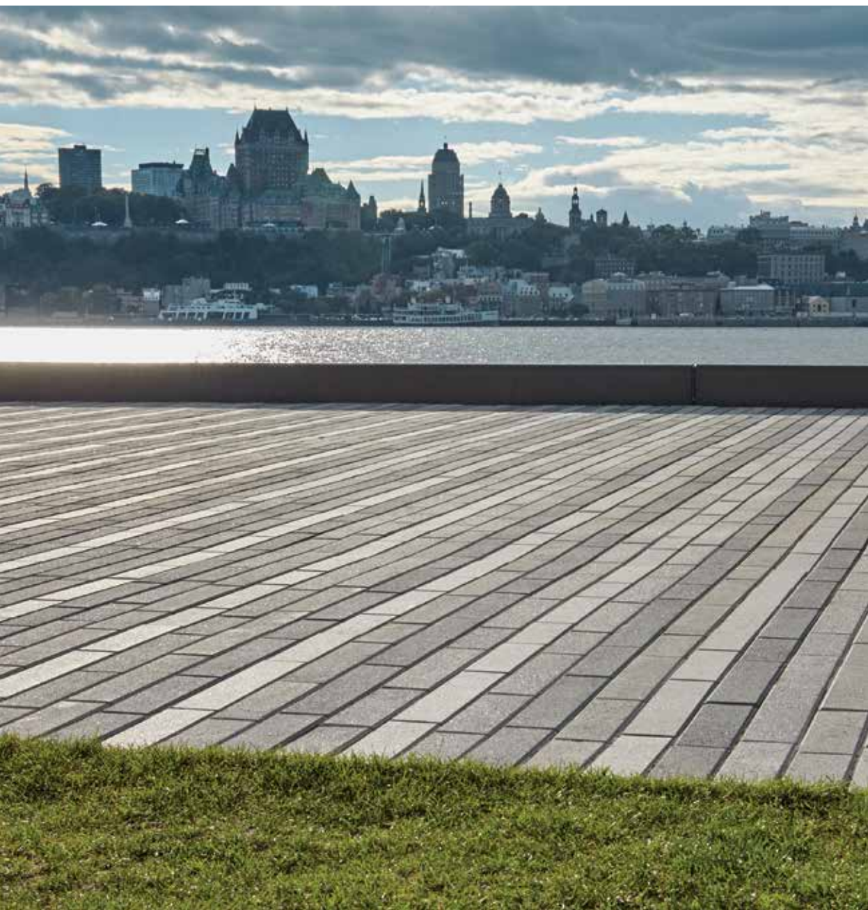
Réhabilitation du Quai Paquet, Lévis BOULEVARD TLI 150 CRESCENDO 125
