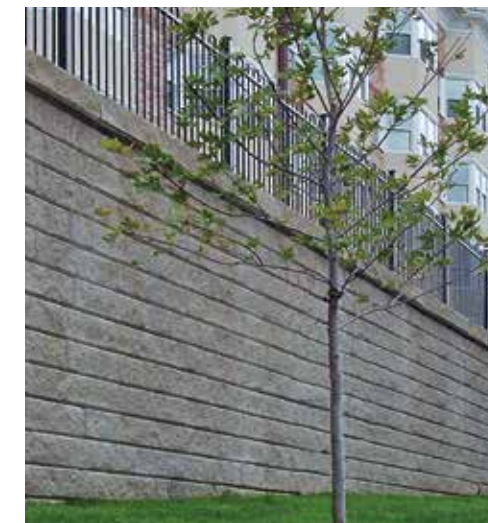
Intégration de clôtures directement au-dessus du mur.
