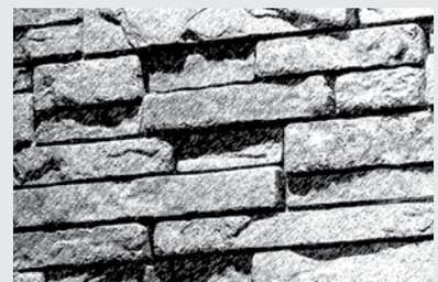
Une fois l'installation complétée, nettoyez le mur avec une brosse à poils rigides en prenant soin de ne pas laisser un surplus de mortier. Enlevez tout résidu de pierre qui pourrait être emprisonné dans les faux joints à l'aide d'une truelle, spatule fine ou tout autre outil. Laissez le mur sécher environ 24 heures ou jusqu'à ce qu'il soit complètement sec. Lavez au besoin avec un détergent à maçonnerie recommandé par Permacon. Répétez si nécessaire.
