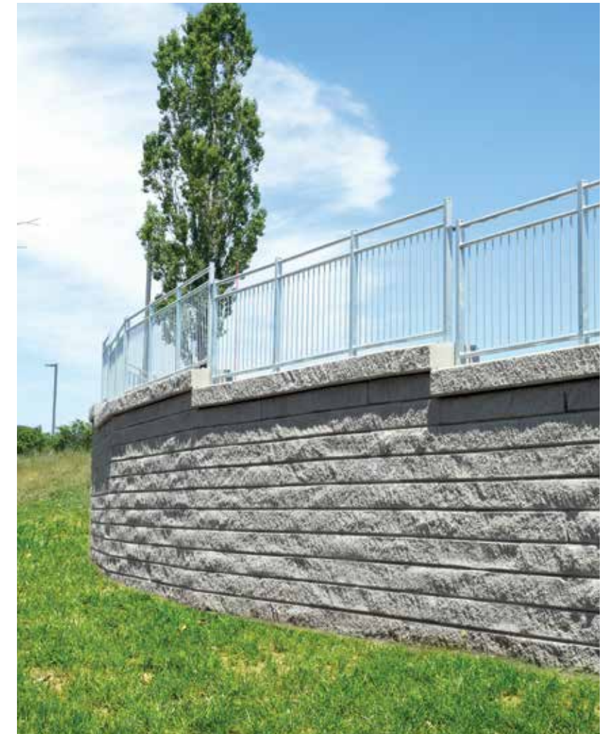
Construction de murs de grande envergure en ligne droite et même en courbe.
