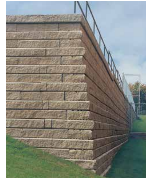
Le recours à des géorilles permet de gagner en hauteur et minimiser les coûts de construction.
